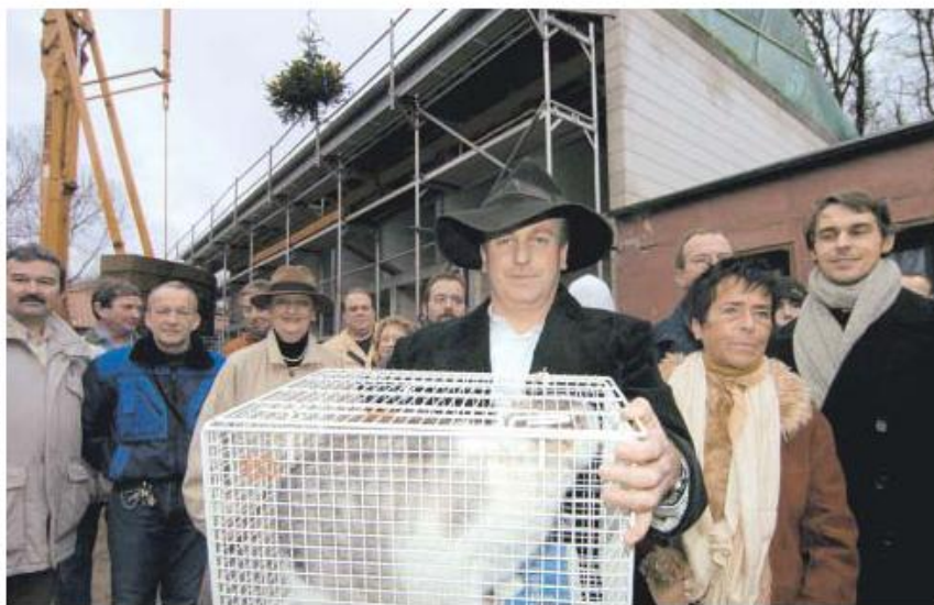
Zimmermann Günter Fell, Tierheim-Chefin Ingrid Weber und Bauleiter Mike Gorges (vorn, von links) feierten am Freitag mit vielen Gästen Richtfest am Katzenhaus. Kater Carlos (im Käfig) und seine Artgenossen sollen im Frühjahr die zwei Etagen beziehen. Aber natürlich ist ihnen eine neue Familie noch lieber. Foto: Becker & Bredel
